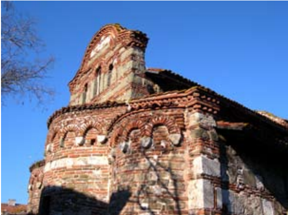
Fig. 10. Mixed masonry 'opus mixtum'
