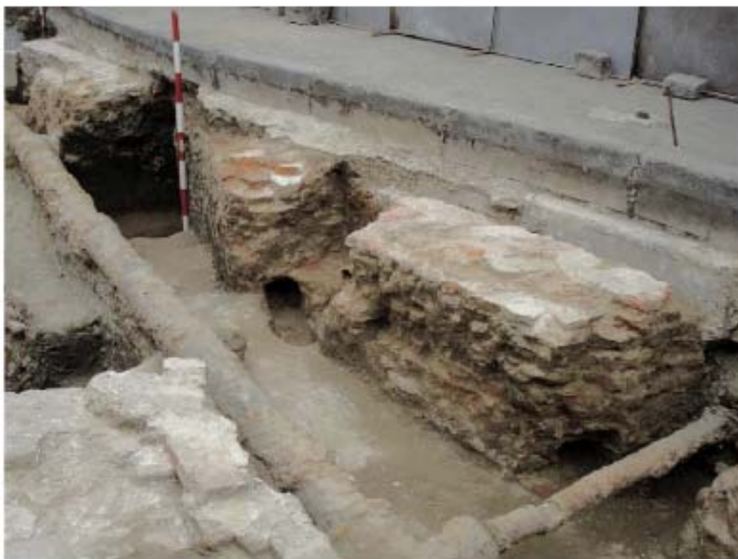
Tiranți în zidul de fundație sud-vestic
