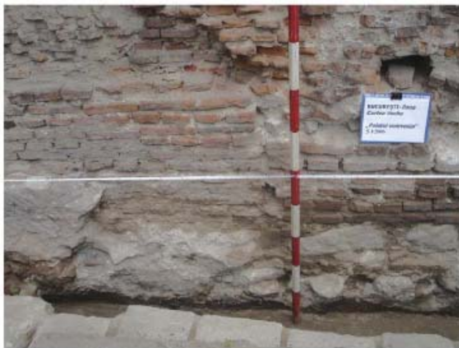
Palatul voievodal Curtea Veche, S I/2006, detaliu de zidărie (zid din bolovani de râu din secolul XVI suprapus de ziduri de cărămidă din secolul XVII)
